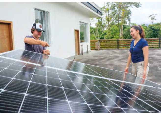
Prof. Dr. Matthias Schirmer und Katherin Morales bei der Installation einer autarken PV-Anlage in einer Forschungsstation im Bioreservat Colonso Chalupas im ecuadorianischen Amazonasgebiet; Foto: Andrés Chamorro
