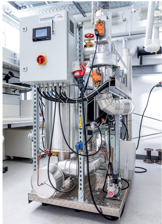
Wärmespeichertestanlage im Technikum der EAH
