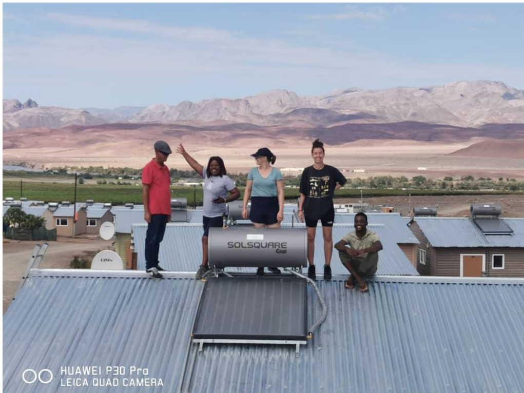
Inspektion von Solar Water Heater Systemen während des Praktikums
