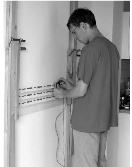
Ausmessen der Störfeld-Verteilung an einer Wand.
