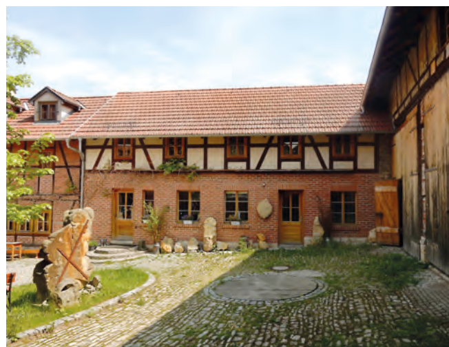
Der Innenbereich des Vier-Seiten-Hofs
